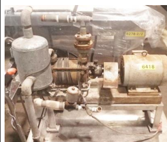
6418 水封式真空ポンプ (2.2kW)
